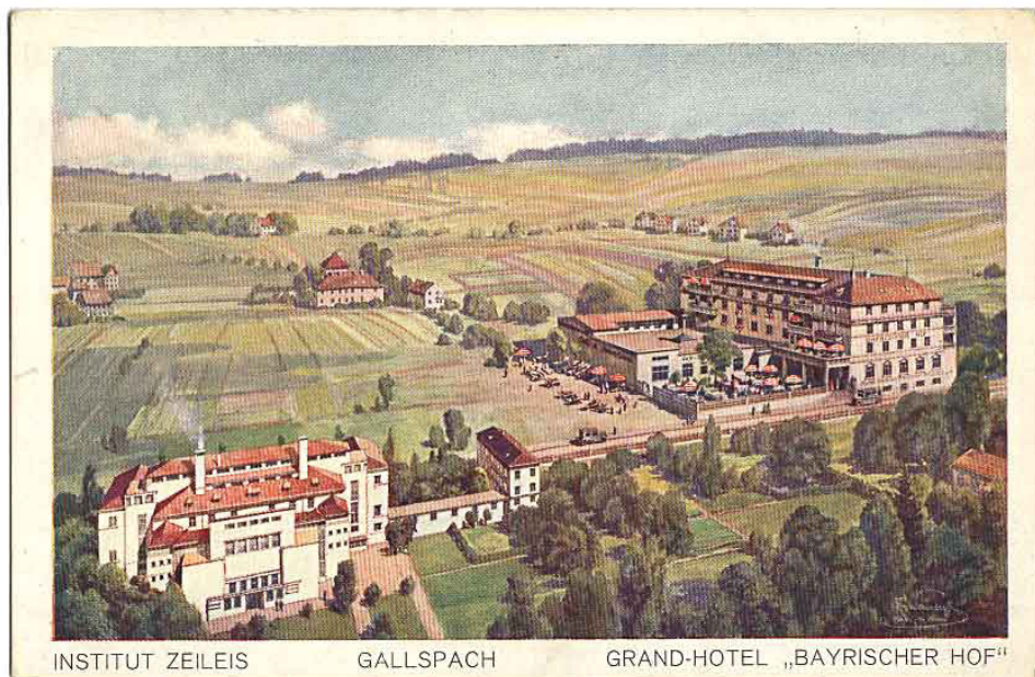
Abb. 5: Ansichtskarte, Farblithographie, ca. 1930. Institut Zeileis (1929 in sieben Monaten Bauzeit erstellt) und das eigens für solventere Heilungssuchende in dem kleinen Ort Gallsbach errichtete Grand Hotel „Bayrischer Hof“, erbaut 1930. Beide Gebäude existieren noch heute. Ebenfalls 1930 entstanden weitere Hotel- und Herbergsbauten aller Kategorien, um dem Patientenansturm zu begegnen. (Slg. d. Verf.)
